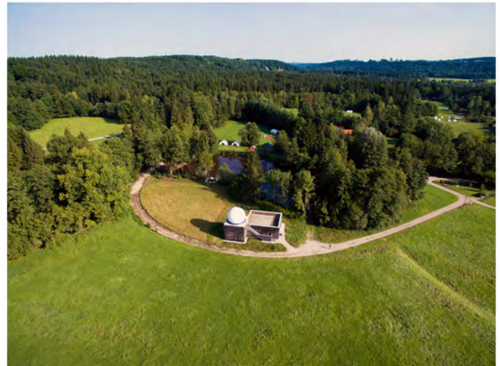
koe_016 Isartalsternwarte, Blick Nord
