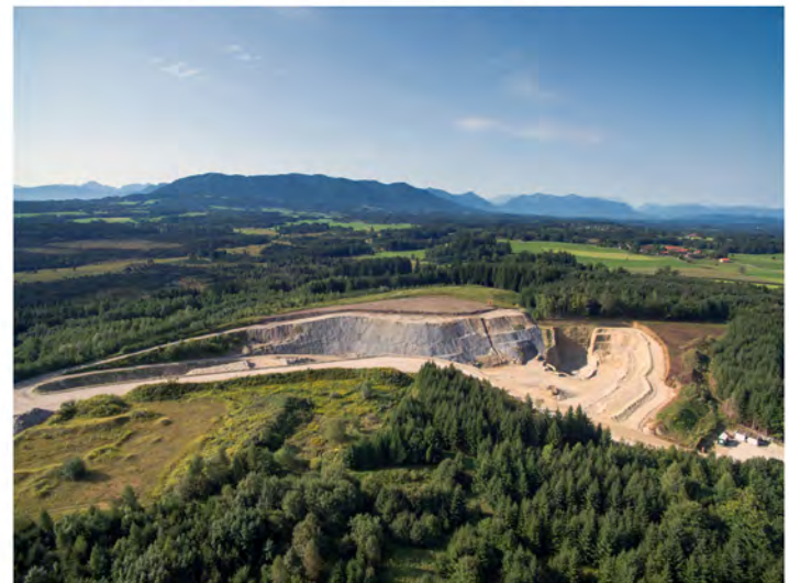
koe_018 Kiesgrube Königsdorf, Blick Süd
